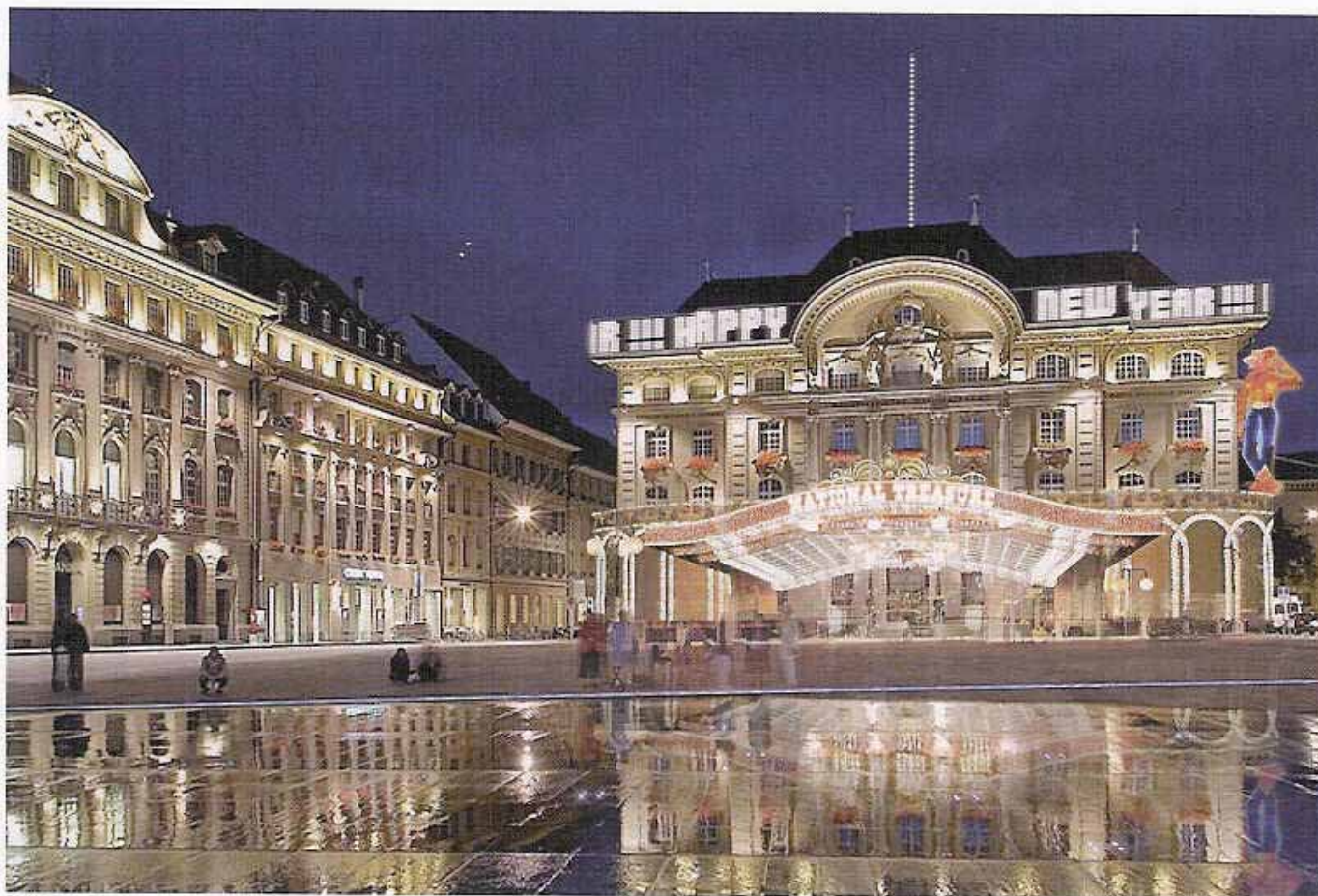
SANIEREN LIMBÄHNEN RENOVIEREN
